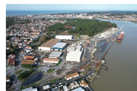
Travaux de construction du quai Gommès
