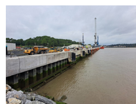
Travaux de construction du quai Gommès - vue de l'alignement des quais de Blancpignon depuis le plan d'eau
