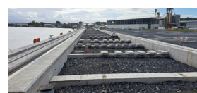
Travaux de construction du quai Gommès
