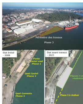
Vue du terminal portuaire de Blancpignon avant travaux (Anglet, 64)
