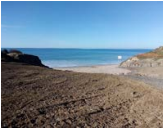
Fin de réaménagement lourd du site avant végétalisation.
