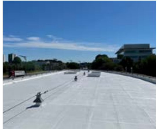
Toit terrasse blanchi pour un fort albédo
