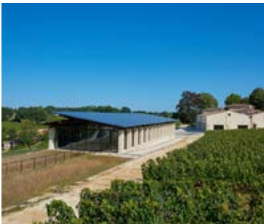
Couverture photovoltaïque du chai inclus dans la pente du coteau
